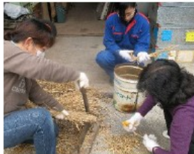
モルタルと砂に混ぜる藁(わら)を切る
