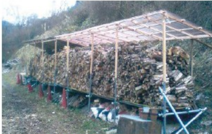
新しく設置された薪棚の屋根
