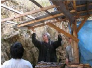
廃材活用で軒を製作！
