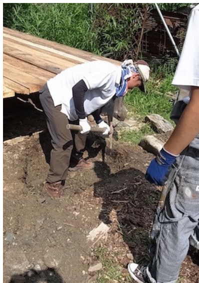
下段 庵プロジェクトの活動風景 踏石用の穴掘りと移設途中の踏石 (伊達冠石)
