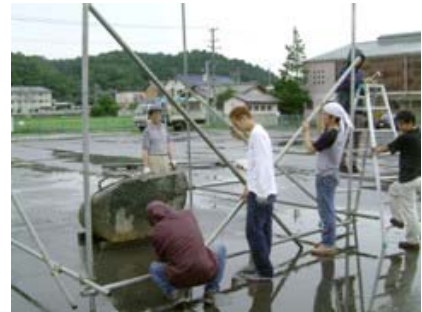
屋外制作場の設営 (7/19) 小雨の中、エイヤーで単管を組み上げる。資材提供は社教の澤田さん。感謝！感謝！
