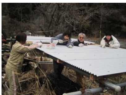
トタン屋根を新たに設置
