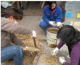
モルタルと砂に混ぜる藁(わら)を切る
