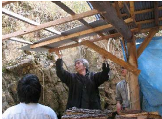
廃材活用で軒を製作!
