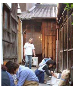
石置の玄関口で石膏流し込みの作業
