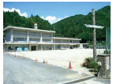
矢持地区市民センター(旧矢持小学校)
