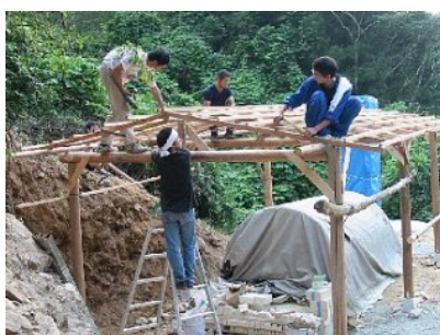
8/13 屋根の棟上げ→気を付けて！
