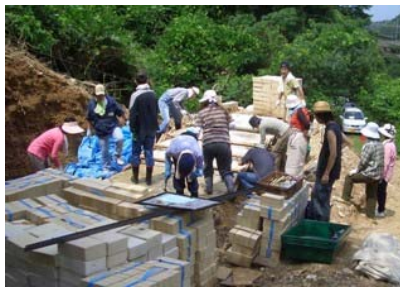
型枠を取り外すところからスタート
