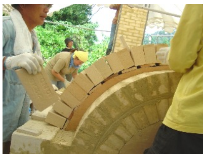
8/9 アーチ部・屋根を積んでいきます
